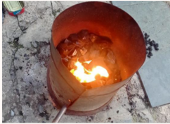
Figura 3 – Fornalha utilizada para o derreter o Betume.
