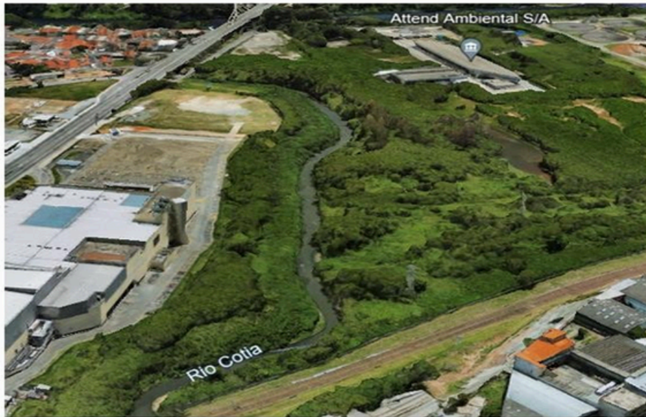
Figura 04: proposta de implementação do Wetland na Av. Santa Terezinha, atrás do Parque Shopping Barueri
