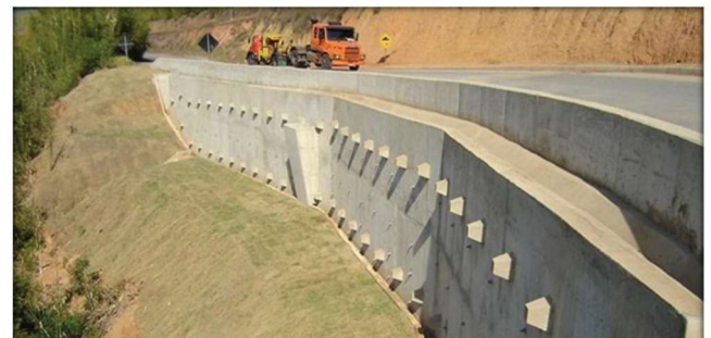
Figura 4 – Cortina atirantada em concreto armado contendo encosta em estrada. Fonte Acervo Geosonda - WEB
